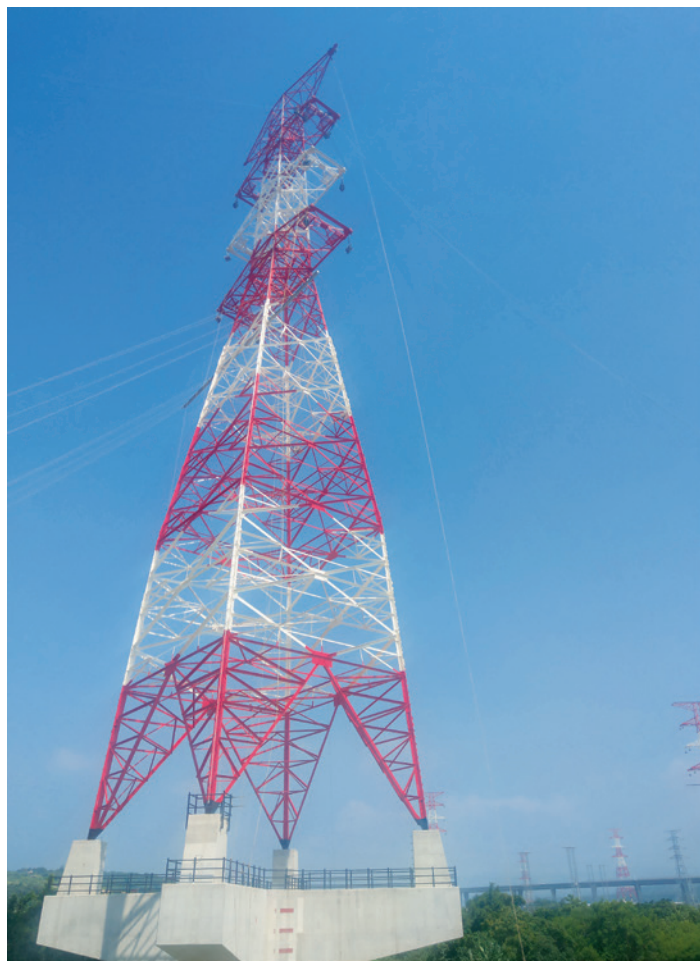
▲ 高壓電塔為了航空安全漆上醒目的顏色。
