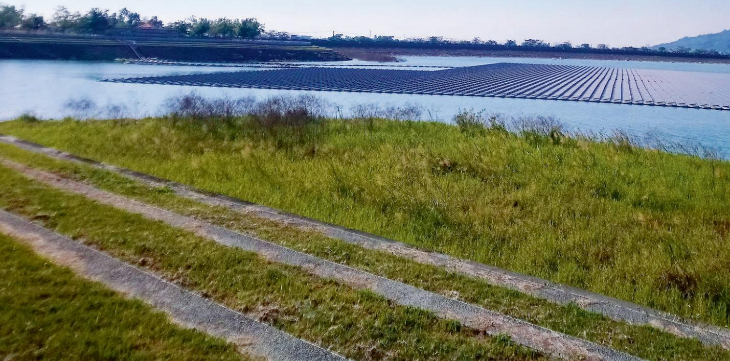
▲ 浮力式太陽能板的岸錨與上岸輸電線的引接處，浮力式太陽能板為防止水流將太陽能板帶走，除了有水下錨座外，還加設有岸錨固定。
