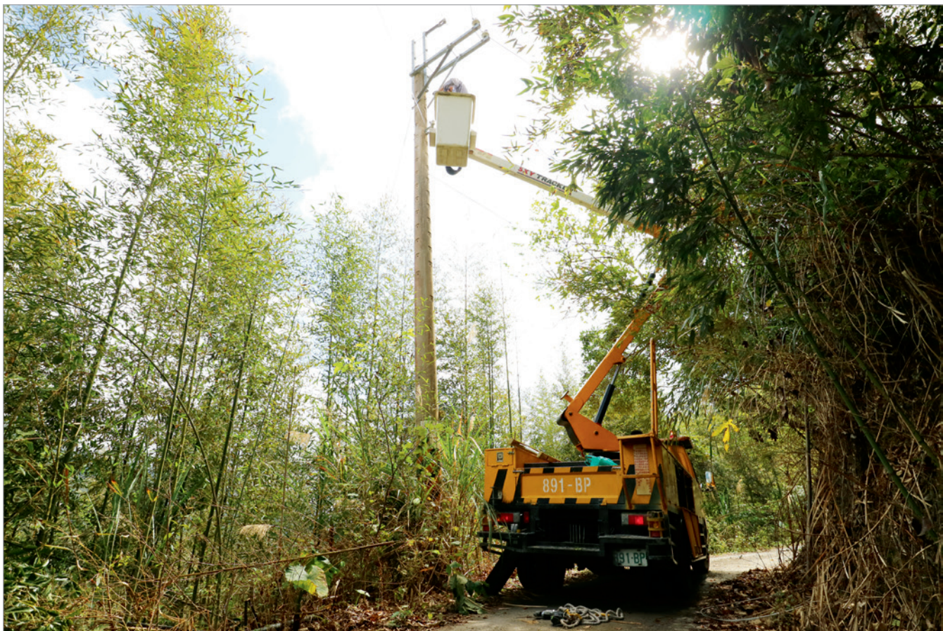
▲ 正在深山竹林中做斷線修復的關山服務所同仁與升空車。
