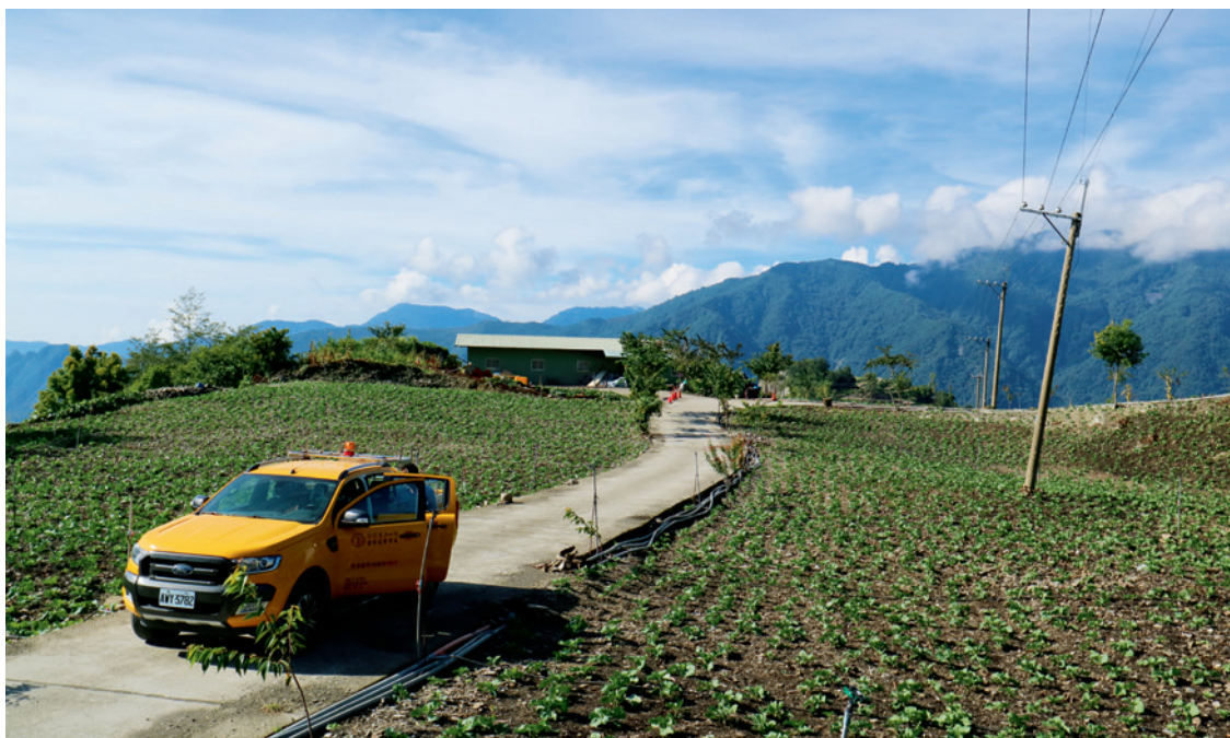
▲ 遊走在南橫東段摩天農場的臺東區營業處工程車與一旁魚貫前行的利稻分線，捍衛這條電力長城的重任就落在關山服務所同仁肩上。
