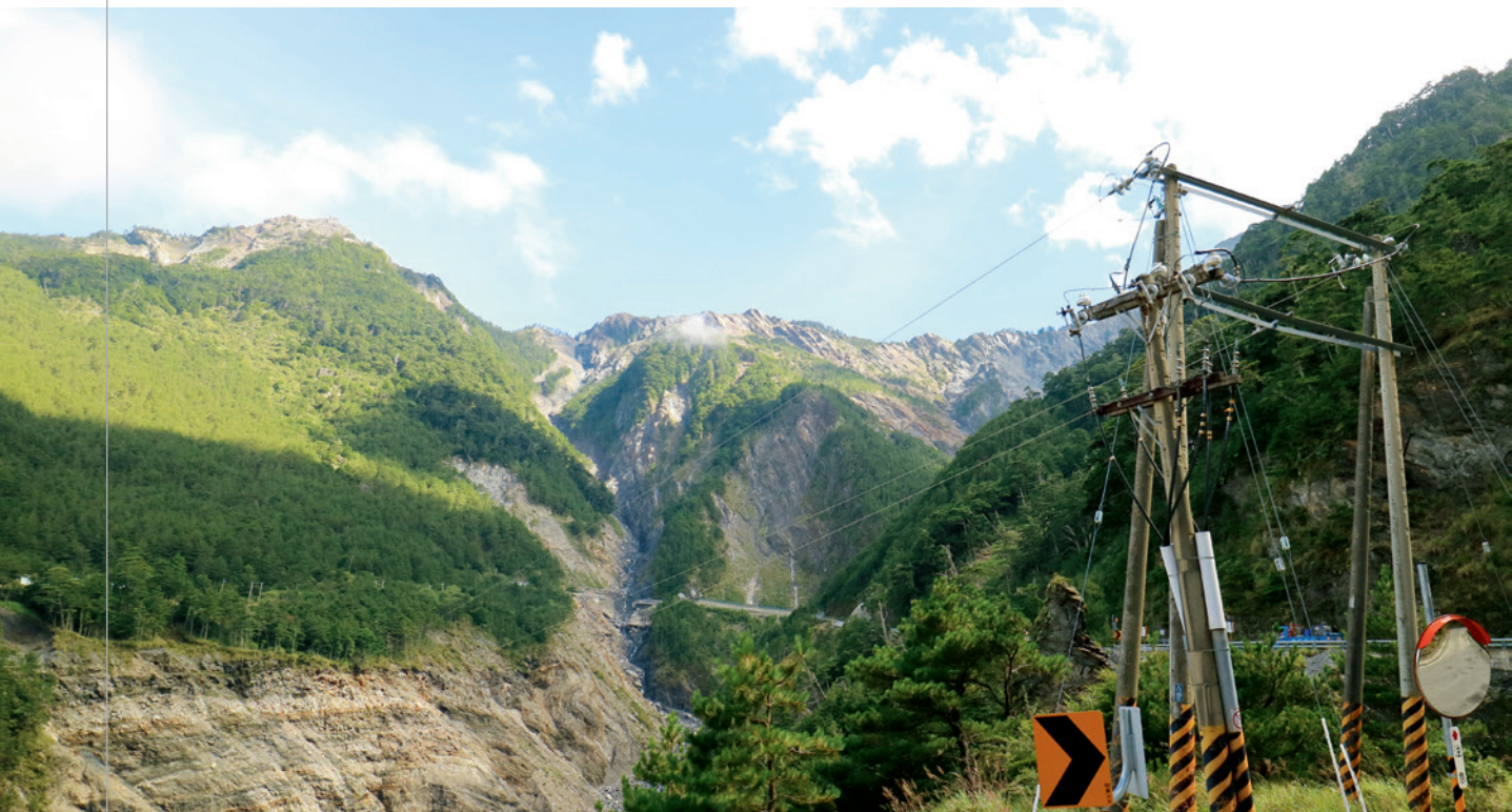
▲ 穿梭在南橫東段的海端幹線利稻分線，後方就是聞名遐邇的向陽大崩壁。
