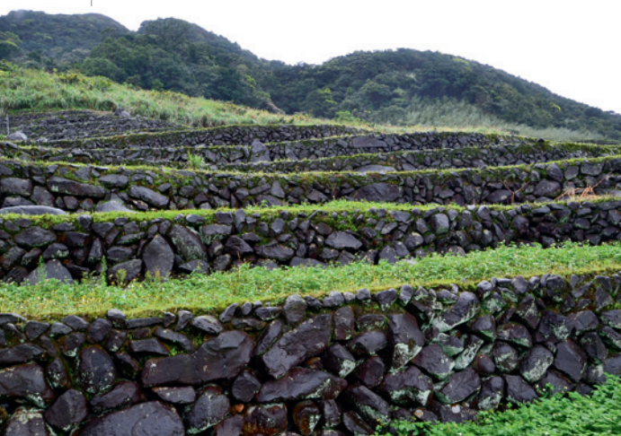
▲ 百年石砌梯田以火山岩堆砌而成，呈現出在地先民砌石工法的智慧結晶。
