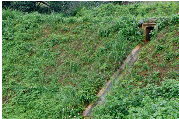
▲ 獨特的「水閘」，由高至低，通過修葺完整的水圳引水，讓水梯田的蓄水調節功能更強。
