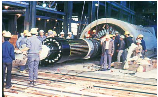
▲ 民國 65 年協和發電廠進行發電機轉子的安裝工程。
