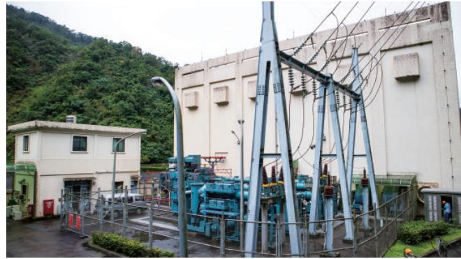
▲ 翡翠發電廠的開關場，發電機發出的電力經由此輸送至台電的輸電網路中。
