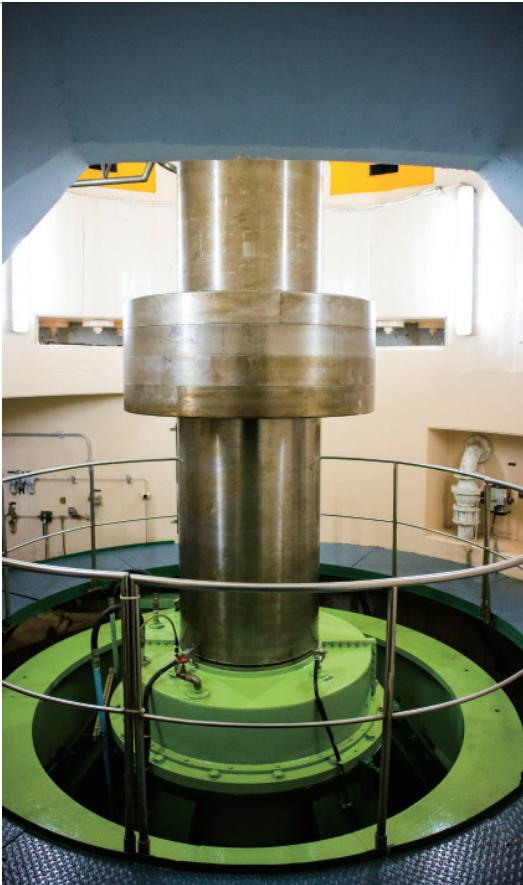
▲ 水車室中連接下方水輪機與上方發電機的軸承。
