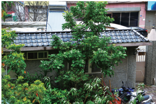
▲ 除了太陽光電筆，警衛室的屋頂架設了太陽能熱水器，也是國小校園少見的一景。
