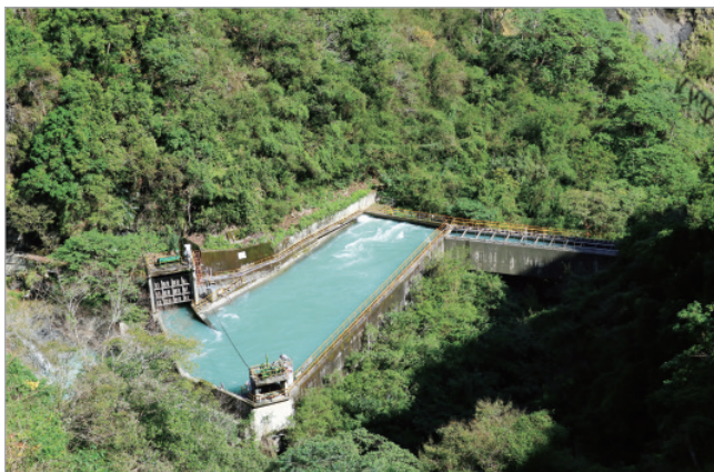
▲ 義興發電廠兩段輸水隧道之間的匹亞溪沉砂池，呈現精巧的「之」字形流水。
