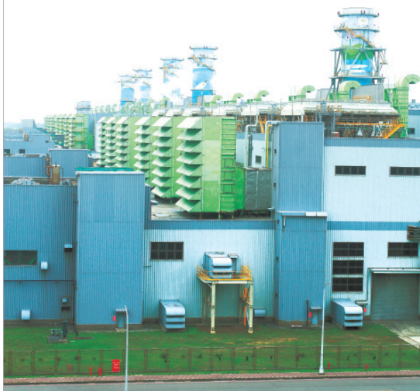
▲ 大潭發電廠以觀音蓮花為主的彩繪煙囪。
