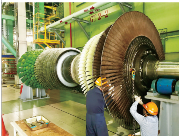
▲ 大修中的大潭發電廠機組。
