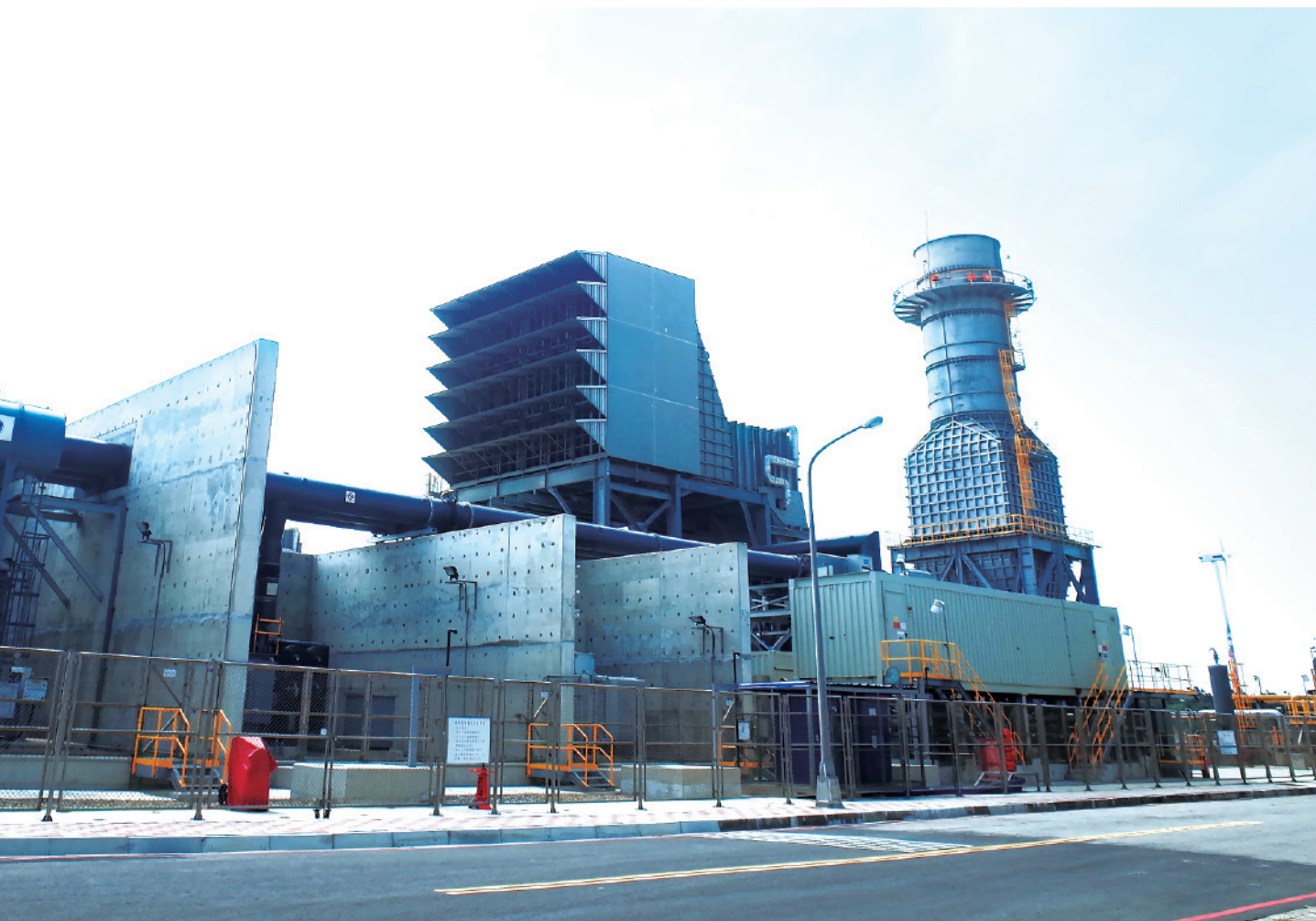
▲ 大潭電廠新建中的第 7 號複循環機組。
