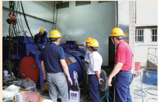
▲ 后里圳低落差示範電廠台電接手後大修工作。
