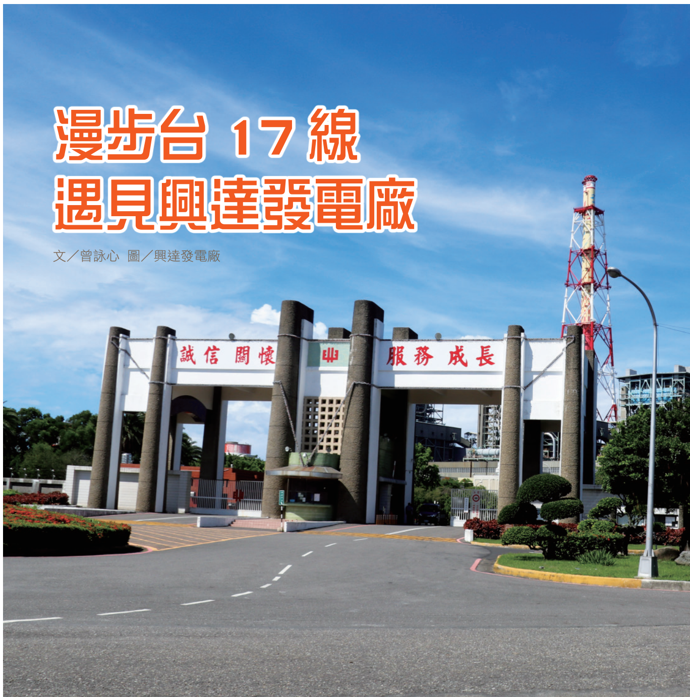
▲ 高雄興達發電廠現況。
