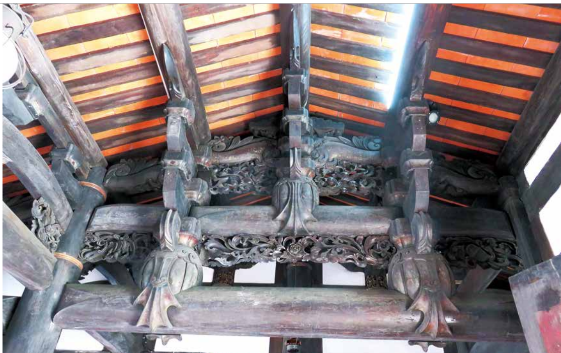
▲ 斗拱層層往上疊的結構可承載部分屋頂重量。
