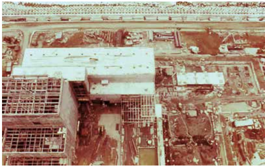
▲ 填海造陸後，民國 63 年協和發電廠進行鍋爐、汽機房建置。
