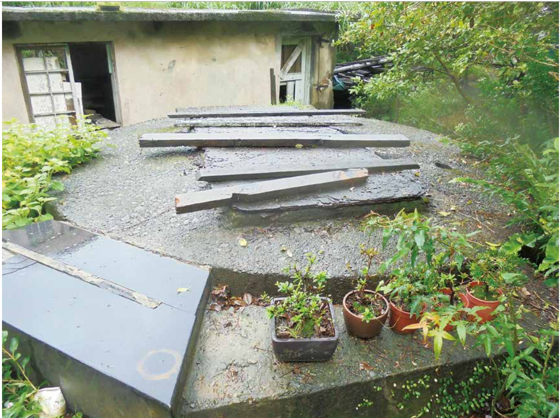
▲ 採用直井機械開鑿礦井的「清國井」遺址，後方的建築物為抽水泵室，抽水送北部發電廠。
